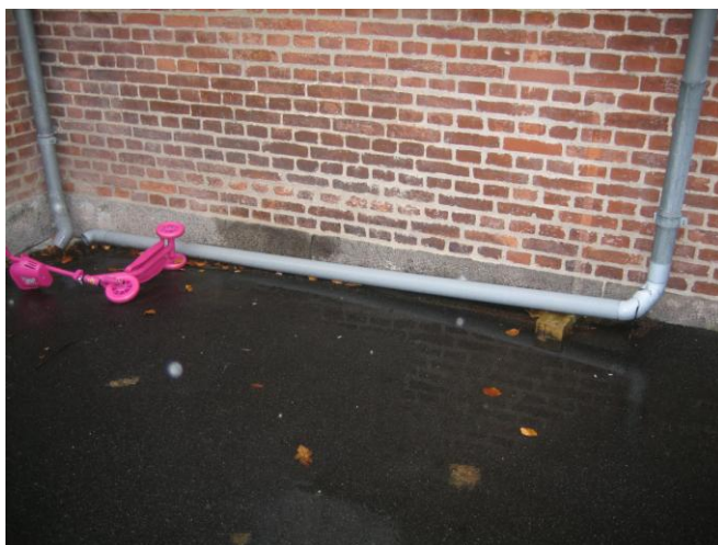
Billede 6. Tagnedløb ført langs facade over til rist, nr. 77A
